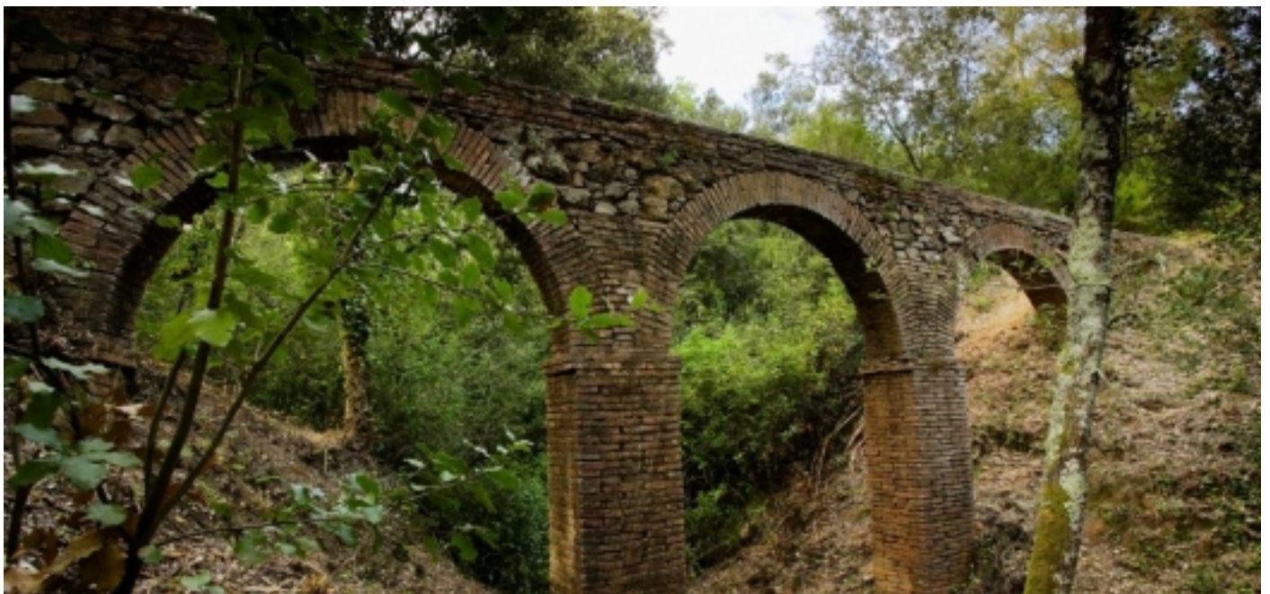
Großes Aquädukt von Can Vilallonga (Konsortium von Les Gavarres). Foto: Oriol Alamy
