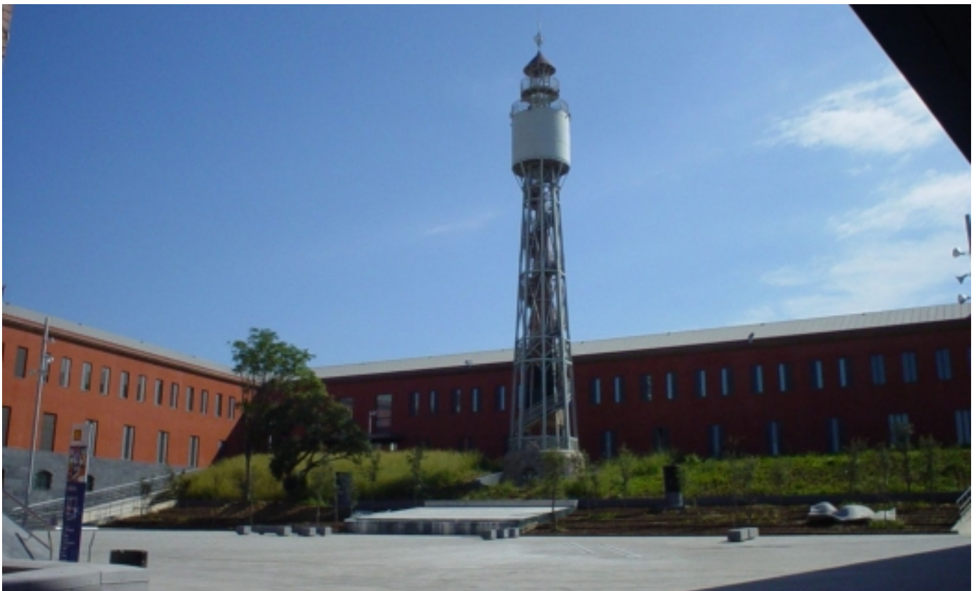
Ehemaliger Wassertank der Korkfabrik Can Mario, Palafrugell. Foto: Àlex Cebollero
