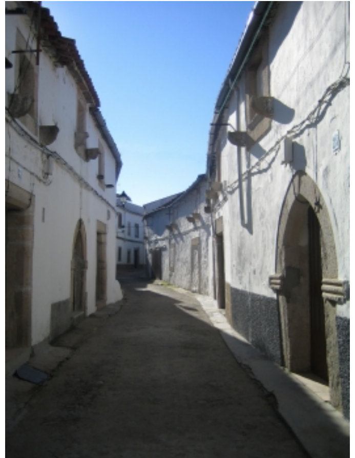
Gotisch-jüdisches Viertel von Valencia de Alcántara. Foto: Gemeindeverband Sierra de San Pedro
