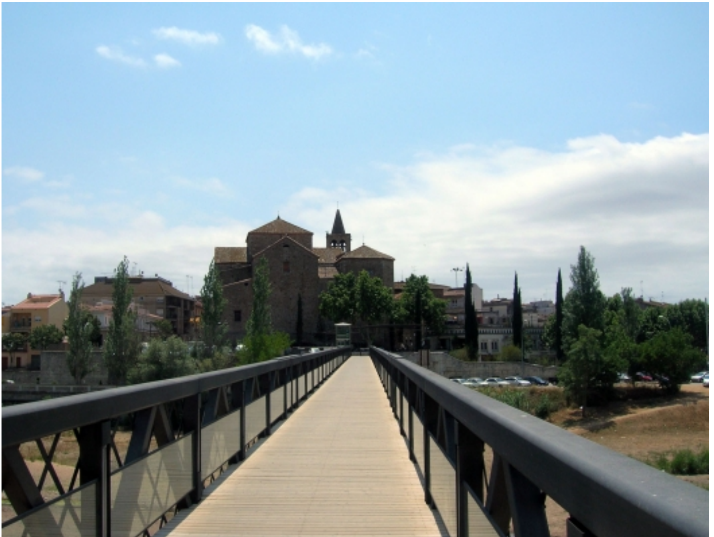
Eisenbrücke, Tordera. Foto: Rathaus von Tordera
